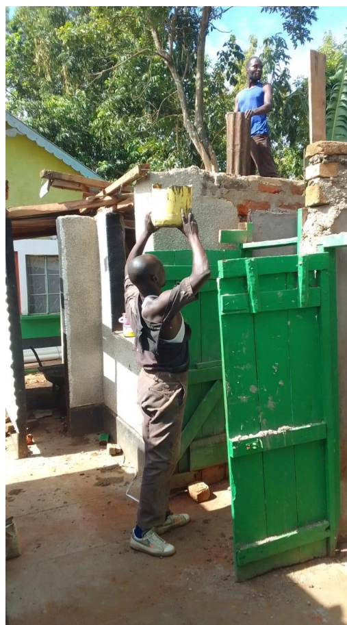
Toaletter under bygging i IW of Safia, Malakisi/Kenya.
